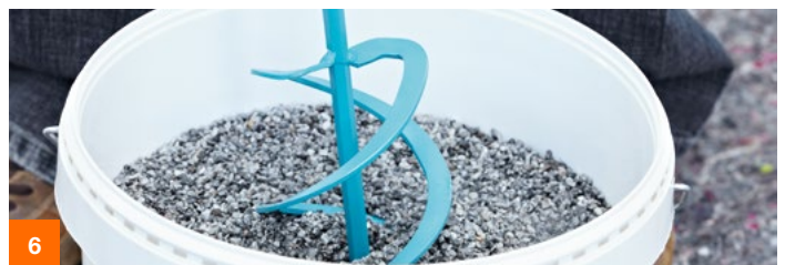
6 quick-mix Naturstein-Teppich mit quick-mix Naturstein-Teppich Feste Wand intensiv mittels eines langsam laufenden Rührgerätes vermischen. Nur so viel quick-mix Naturstein-Teppich anmischen, wie tatsächlich benötigt wird. 20 kg quick-mix Naturstein-Teppich und 100 ml quick-mix Naturstein-Teppich Feste Wand reichen für ca. 1,75 m 2 aus.
