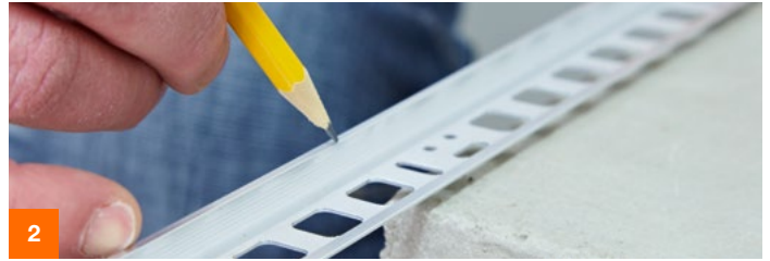
2 Die Position der Abschlussprofile (8 mm Stärke) vorab mit Meterstab und Wasserwaage festlegen und markieren. Anschließend befestigen.
