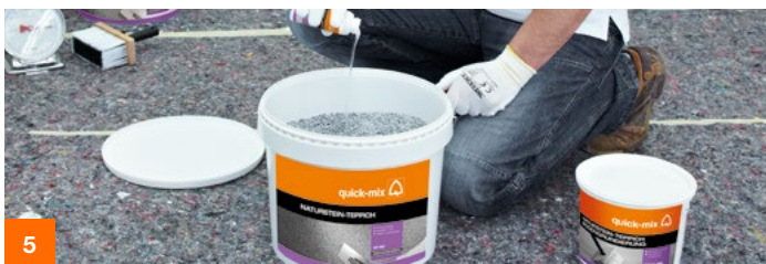
5 Den Eimer quick-mix Naturstein-Teppich öffnen und langsam quick-mix Naturstein-Teppich Feste Wand (100 ml) restlos in den Eimer quick-mix Naturstein-Teppich (20 kg) laufen lassen.
